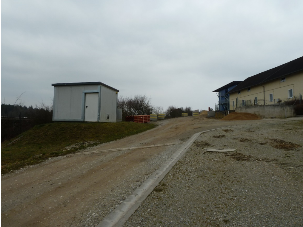
Abb. 2: Ansicht von Osten – Privatweg und Pumpstation, Foto Jocham + Kellhuber (März 2024)
